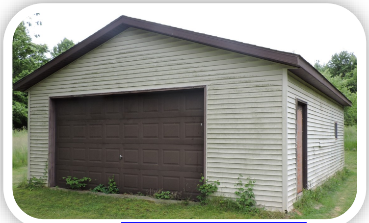
24' X 30' Pole Barn
